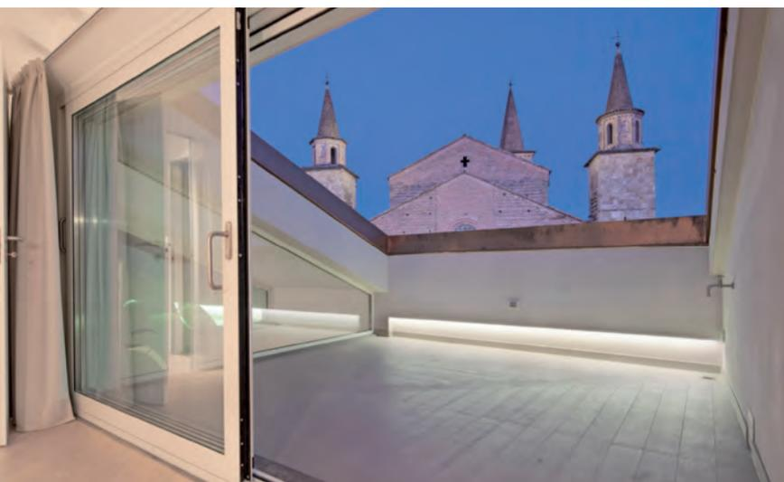
*Le terrazze in copertura a disposizione delle mansarde sono equipaggiate con serramenti scorrevoli di grande dimensione: in questo caso la funzione oscurante è assolta da tendaggi interni*
