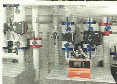
La "Casa sul Parco", nelle immagini, sfrutta l'energia prodotta dalle pompe di calore Vitocal di Viessmann, capaci di attingere da un campo geotermico con otto sonde
